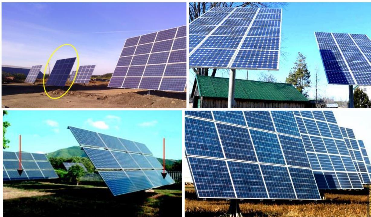
Рисунок 6 - Затенение фотоэлектрических установок с системами слежения за солнцем
